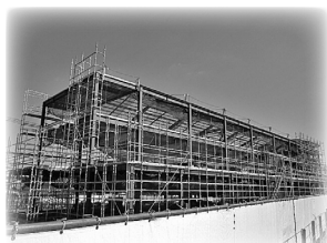
建設中の骨組み
