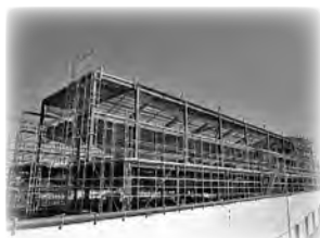
建設中の骨組み
