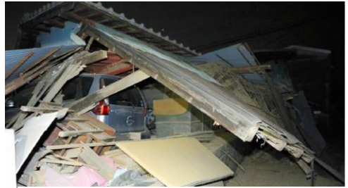
<倒壊した家屋 熊本県益城町>
